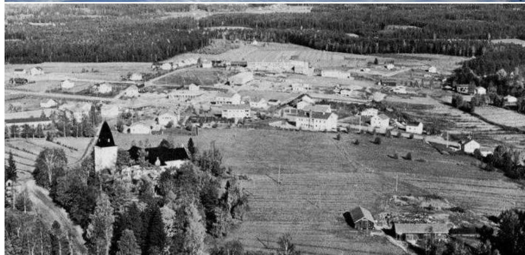
Kuvat: Vasemmalla ylhäällä kunnantalo, alla virkailijain asuinrakennus, oikealla ylhäällä entinen kunnanlääkärin virka-asunto ja alla 1960-luvun taitteessa otettu kuva uudesta uudesta keskustasta (Kuva: Kyröskosken perinneyhdistyksen arkisto)
